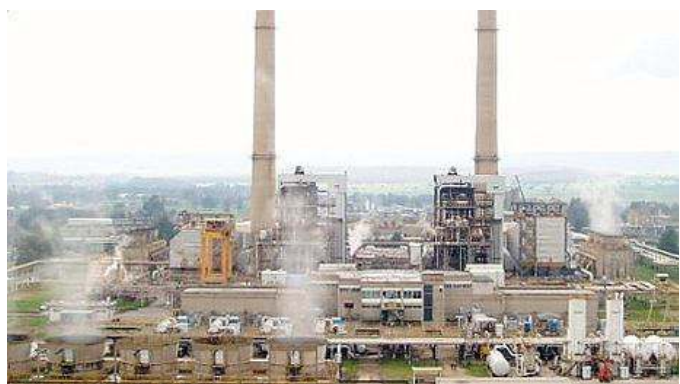
La centrale elettrica di Terna nella zona industriale di Ottana
